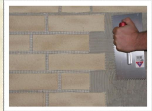
2. Schritt: Die Flächen-Elemente reihenweise von links nach rechts zur Wandmitte verlegen, dann von rechts nach links. Den Zusammenschluss mit Einzelsteinen vervollständigen, wobei die Sturzsteine sehr hilfreich sind. Matten mit einer Gummi-Rolle oder Gummihammer leicht anklopfen
